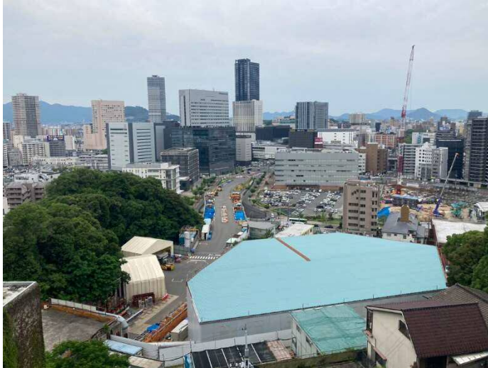
① 高速 5 号線シールドトンネル掘削他工事
