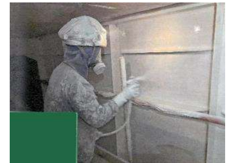
塗装塗替施工状況(上塗り)
