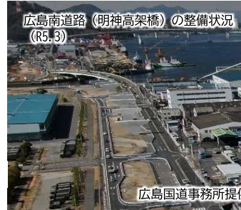
広島南道路(明神高架橋)の整備状況 (R5.3) 広島国道事務所提供
