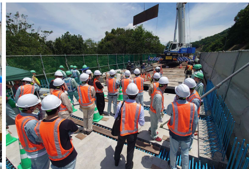
学生向け現場見学会の実施風景 (床版取替え工事)
