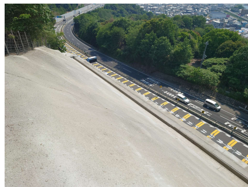
施工後(モルタル吹付)
