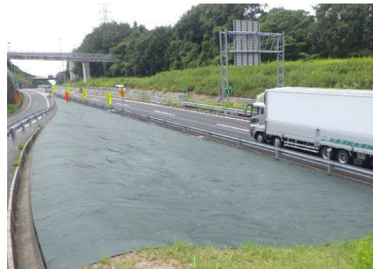
防草対策(張コン・シート)
