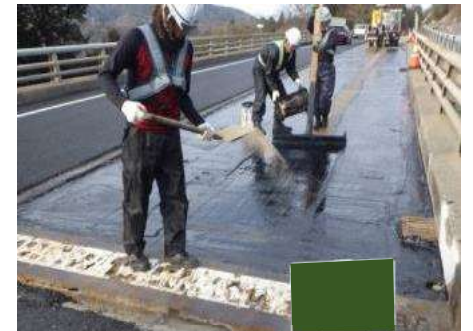
高性能床版防水(複合防水) 施工状況
