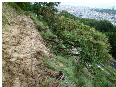
施工前(植生荒廃)
