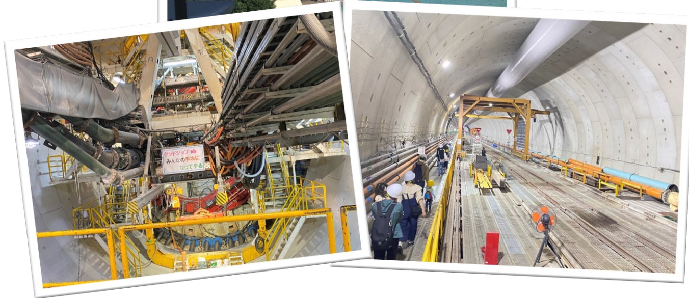
広島高速5号線二葉山トンネル 工事現場の様子
