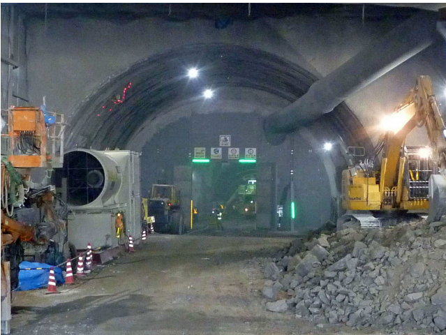
写真② NATMトンネル工事(中山側)(R1.7時点)
