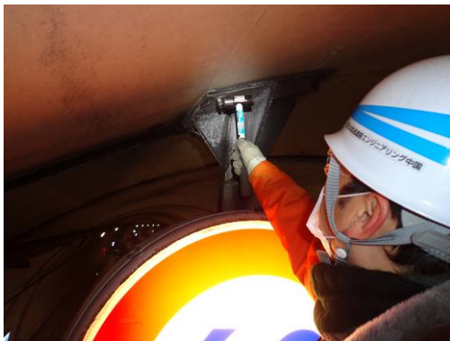
福木トンネル(標識)
