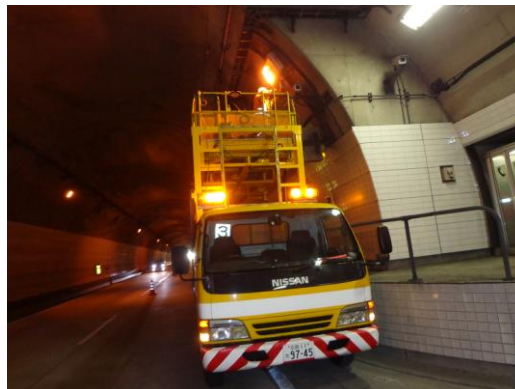
照明施設点検状況
